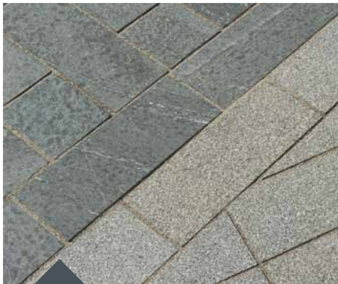
Project Schieveste – Schiedam
