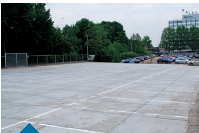
Project Politiebureau – Rotterdam Tijdelijke parkeerplaats
